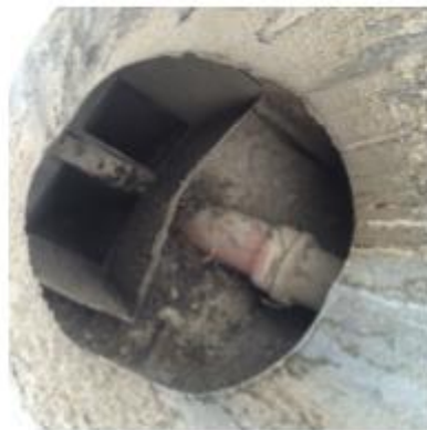
Čištění rotačním kartáčem vč.dezinfekce - odsáté množství prachu z jednoho potrubí.
