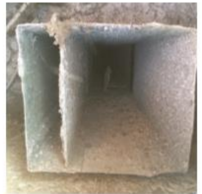
Čištění rotačním kartáčem vč.dezinfekce - odsáté množství prachu z jednoho potrubí.
