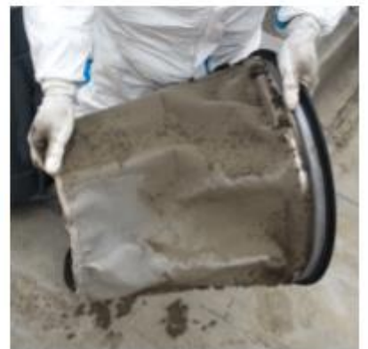
Čištění rotačním kartáčem vč.dezinfekce - odsáté množství prachu z jednoho potrubí.
