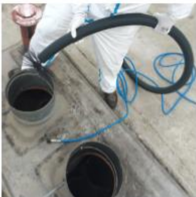
Čištění rotačním kartáčem vč.dezinfekce - odsáté množství prachu z jednoho potrubí.
