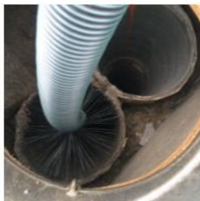
Čištění rotačním kartáčem vč.dezinfekce - odsáté množství prachu z jednoho potrubí.
