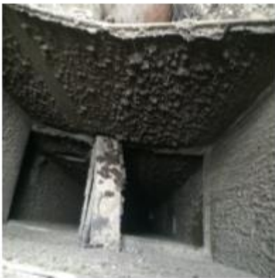
Čištění rotačním kartáčem vč.dezinfekce - odsáté množství prachu z jednoho potrubí.
